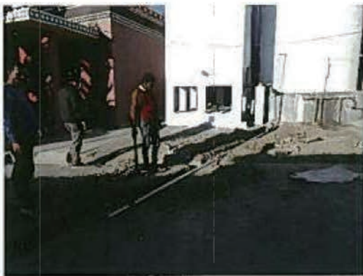
水槽・上下水道設置 (カムラオ)
