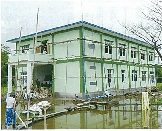
急ピッチで建設が進む人材育成研修センター
